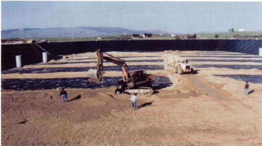
*Fase di impermeabilizzazione della vasca del IV settore della discarica*
