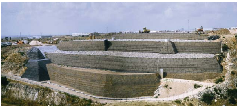
Consolidamento mediante recupero volumetrico del lato Sud-Est della discarica "Pariti 2" di Manfredonia (FG) – Panoramica stato finale.
