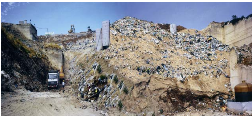
Consolidamento mediante recupero volumetrico del lato Sud-Est della discarica "Pariti 2" di Manfredonia (FG) – Panoramica stato iniziale.
