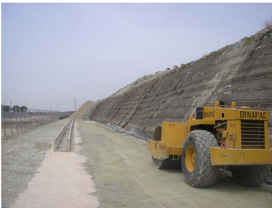
Lavori di ampliamento plano-altimetrico nella discarica di Foggia – Fonte sud-ovest Chiusura e compattazione dello strato di sottofondo.
