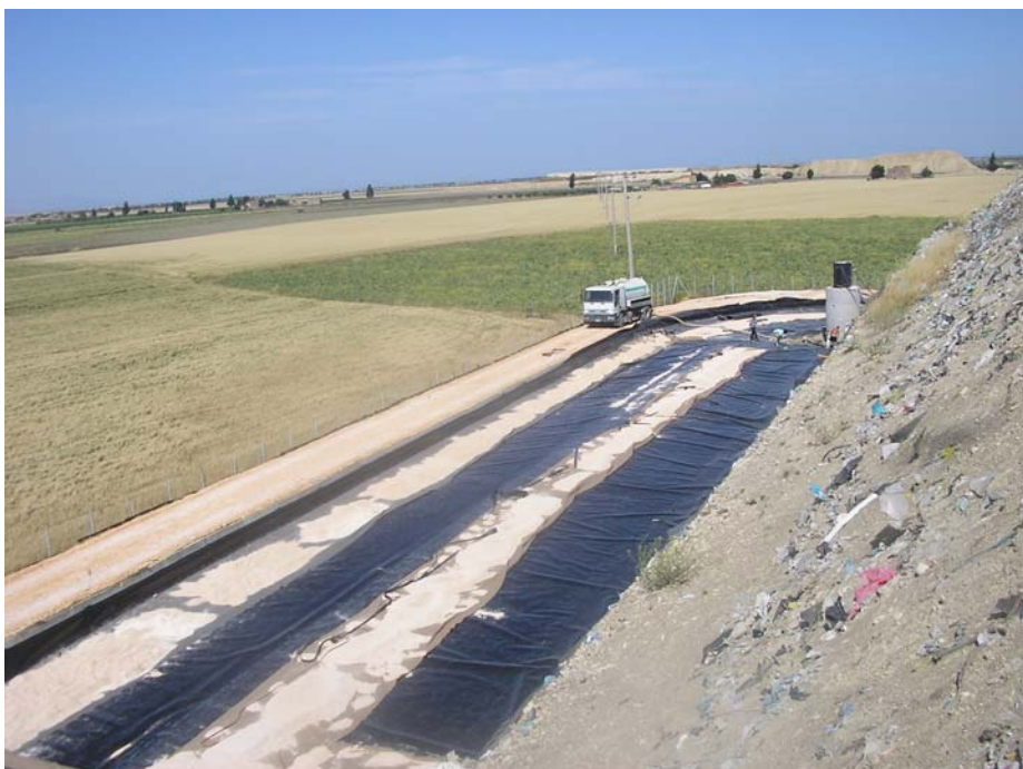
Lavori di ampliamento plano-altimetrico nella discarica di Foggia – Fronte nord-est. Realizzazione della impermeabilizzazione con telo in hdpe dello strato di sottofondo
