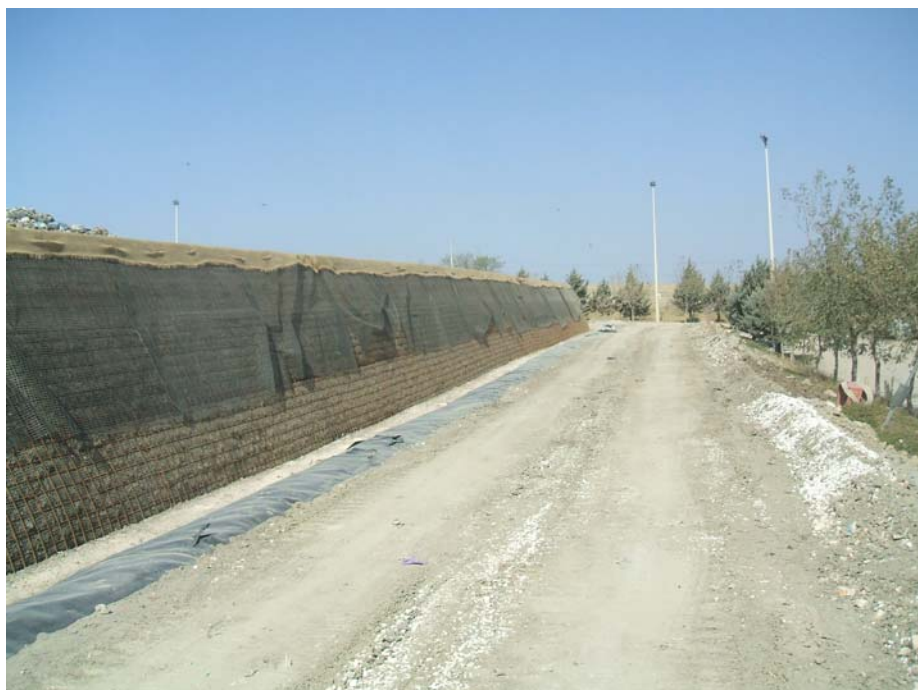
Sopraelevazione della discarica “Masseria Campana” di Deliceto – Fase finale di “Strutture di contenimento per discariche”.
